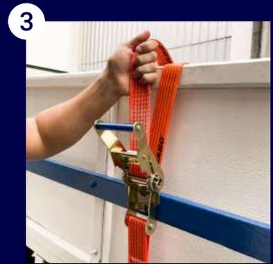
3 Pré-tensionar a fita antes de acionar a catraca.
